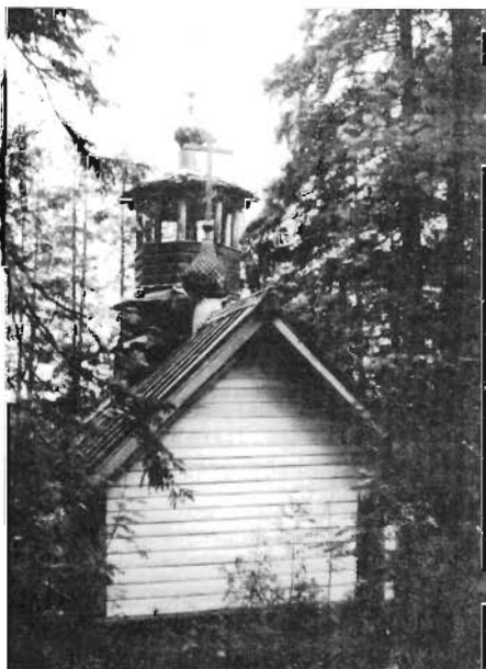
Фото 12. Часовня в лесу у д. Тамбич-Лакта. Восточный фасад
