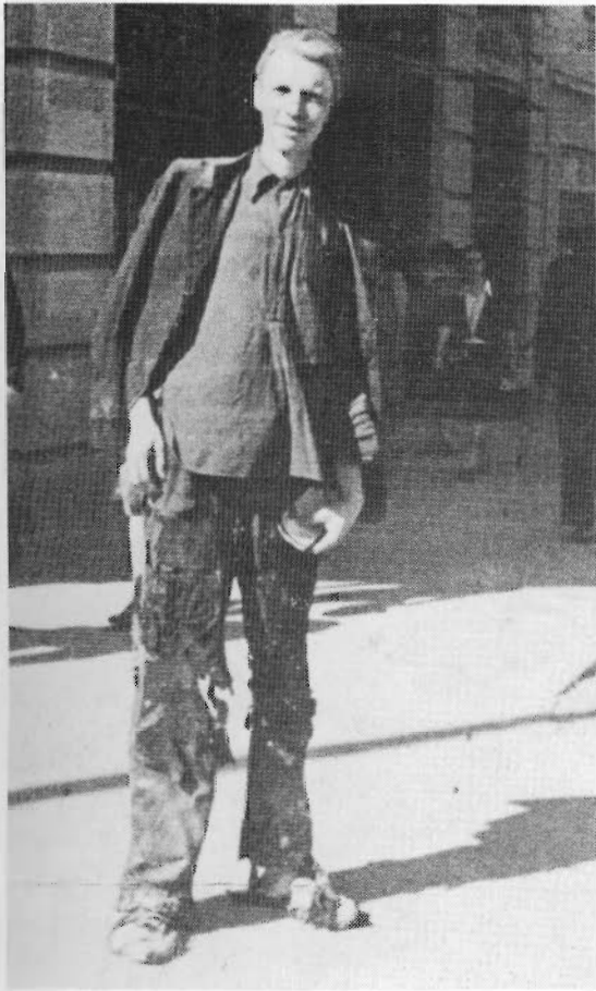
Август 1941 г. Н.И. Толстой, только что окончивший гимназию, работает на восстановлении разрушенных немецкими бомбардировками зданий Белграда. Фото уличного фотографа
