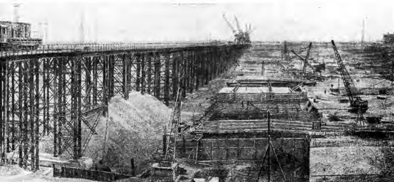
Здесь скоро поднимутся основные сооружения Каховского гидроузла — могучая водосливная плотина и здание гидроэлектростанции.
