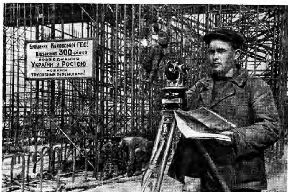
Полным ходом идёт сооружение Каховской гидроэлектростанции на Днепре. Строители трудятся самоотверженно, соревнуясь за быстрееший ввод электростанции в действие, многие, как и бригадир монтажников Анатолий Никуличев, выполняют до трёх норм в смену.
