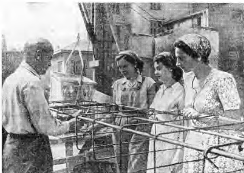
На стройке жилого дома на улице Раковского в Софии. Мастер-арматурищик В. Станев объясняет студенткам архитектурного факультета Политехнического института имени И. В. Сталина, как надо скреплять арматурные каркасы здания.
