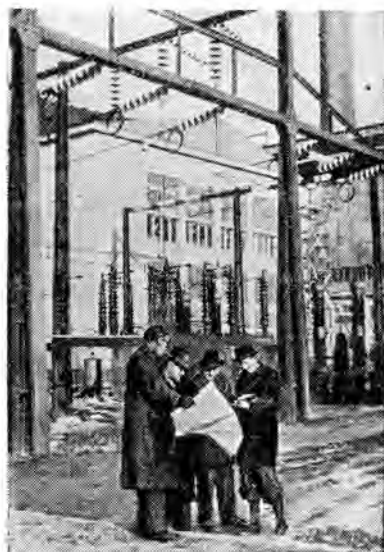
В Земанских Костолах (Словакия) сооружена одна из крупнейших гидроэлектростанций в Чехословацкой Республике. Руководящие работники строительства проверяют монтаж подсобной станции.
