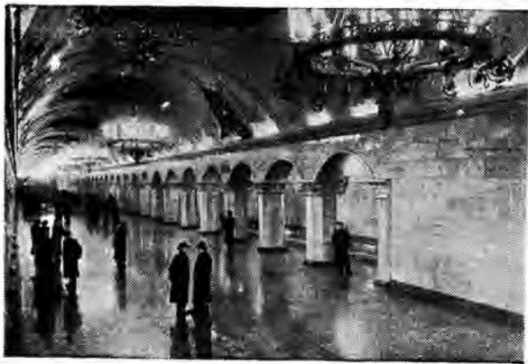
Станция «Комсомольская-кольцевая» Большого кольца. Центральный зал станции, залитый светом, сверкает мрамором, бронзой и хрусталём.
