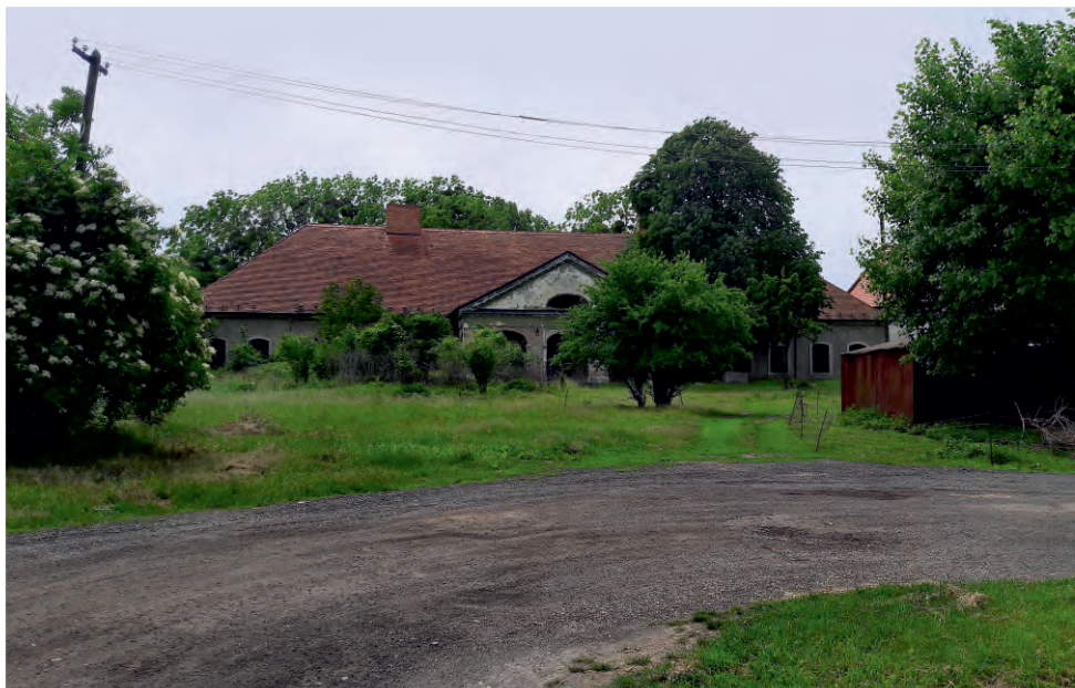
25. Разрушенная барская усадьба в с. Чуново. Фото Д.Ю. Ващенко, 2018 г.
