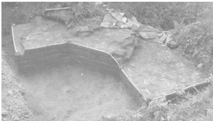
Рис. 2. Раскопанная часть фундаментов западной стены храма.
