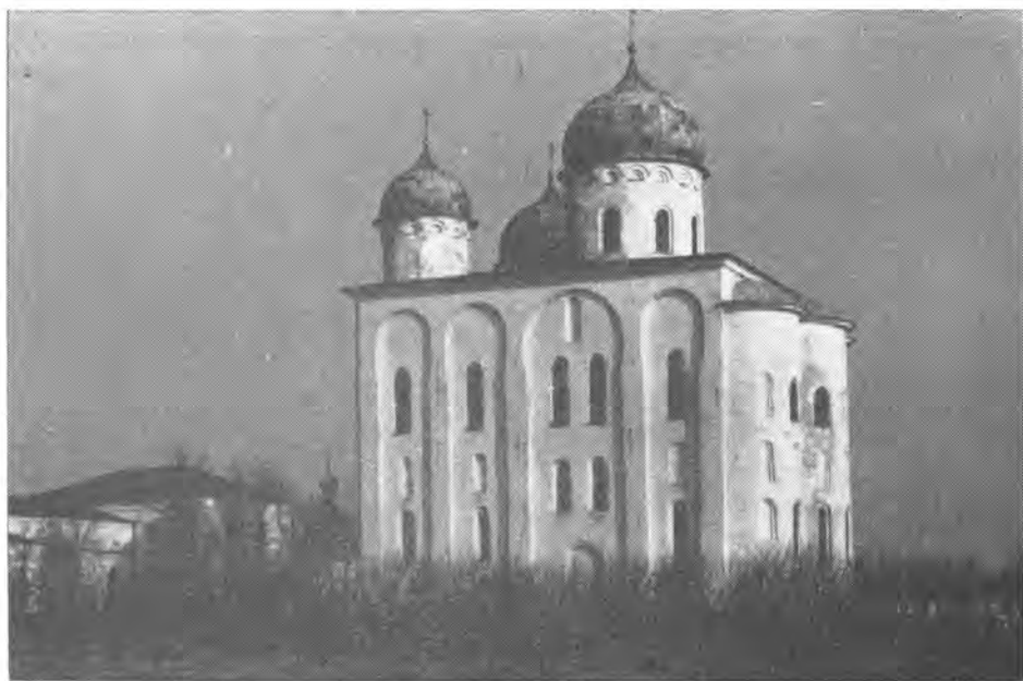
Рис. 11. Георгиевский собор, общий вид с юго-востока
