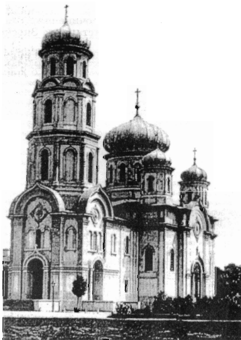
Илл. 14. Собор Воздвижения Честного Креста Господня в Люблине (разрушен в 1924–1925 гг.)
